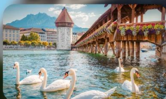
สะพานไม้ชาเปล
